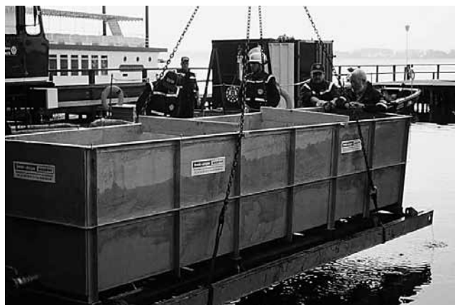
Abb. 6b: Verladen der Bergewanne mit dem Einbaum durch einen Kran des THW Salzwedel.
