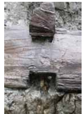
Abb. 6: Verf. 1096, überkämmt Bohlen des in Blockbauweise errichteten Brunnenkastens (Alle Fotos Bundesdenkmalamt).
