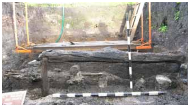
Abb. 5: Ostprofil des Balkens Schnitt 31, Fläche 7. Links die Faschine, nach rechts einer der eingezapften Pfähle, einer der Längsbalken, Pfahlverzug des zweiten eingezapften Balkens. Die Faschinenhölzer enden am zweiten erkennbaren Pfahlverzug in der Mitte des Balkens.
